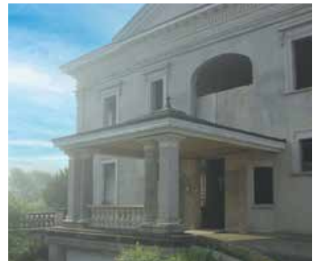
Hier soll einmal das Hotel mit rund 100 Zimmern entstehen.
